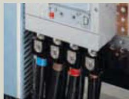
Raccordement de deux conducteurs aluminium 185 mm<sup>2</sup> par pôle sur les bornes réf. 262 51 d'un DPX 630
